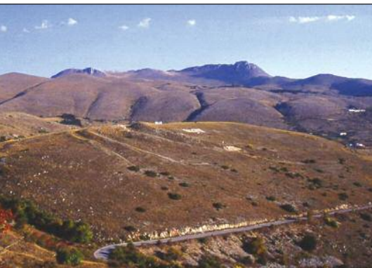
Fig. 2. L'insediamento fortificato di Colle della Battaglia a Castel del Monte (AQ).
